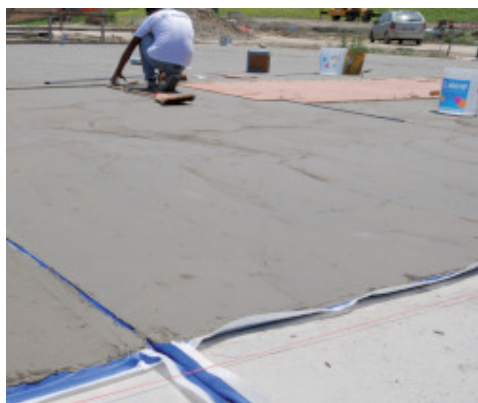
Hidroizolarea sabelor cu Mapelastic si Mapeband
