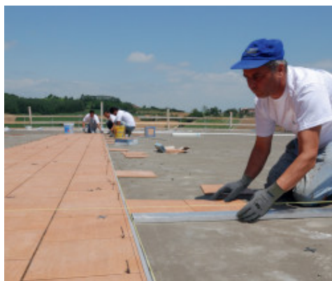
Montarea placilor ceramice cu Kerabond + Isolastic
