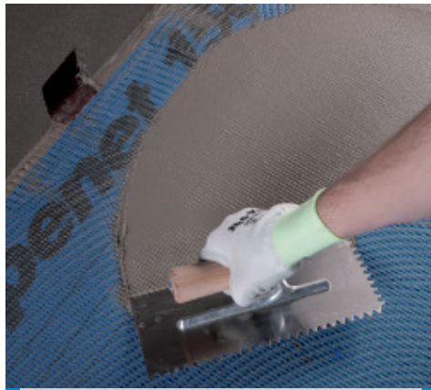
Aplicare Mapelastic pe Mapenet 150
